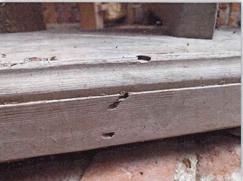
Fot. 4. Policzek schodów prowadzący na empre z widocznym porażeniem przez spuszczała pospo- litego ( hylotrupes bajulus )
