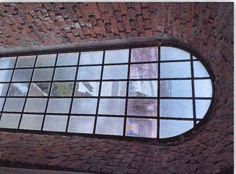
Fot. 3. Okno w centralnej części wieży - widoczny krzyż w kwartale okna - OW/2C
