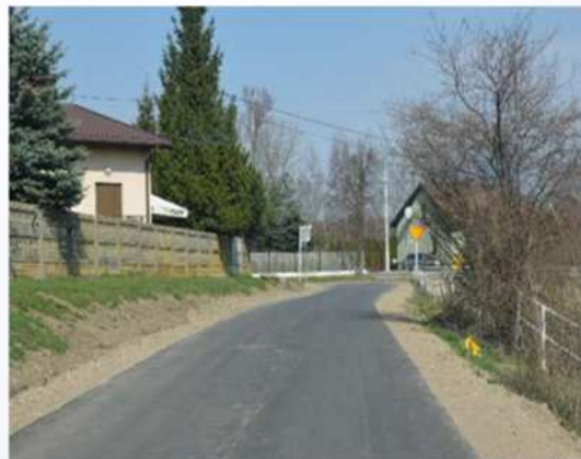
Rempin, ul. Malinowa
