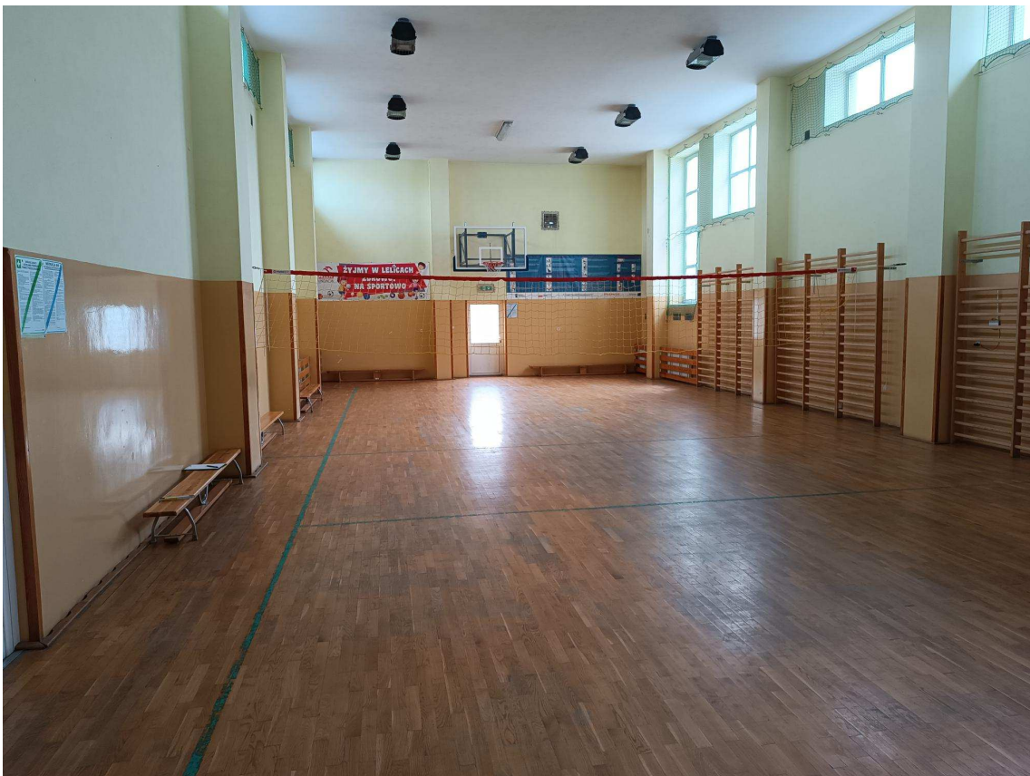
Fot. nr 4 – istniejąca sala gimnastyczna, widoczne zużycie istniejącego parkiet, drabinki gimnastyczne i osłony grzejników do zdemontowania i ponownego założenia.
