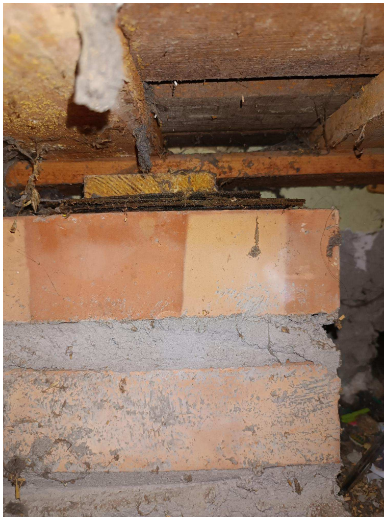
Fot. nr 8 – układ warstw istniejącego parkietu.
