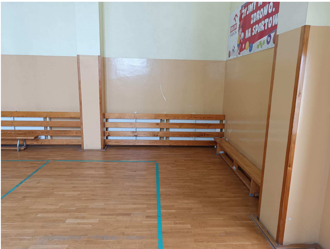
Fot. nr 11 – osłony grzejników do demontażu, czyszczenia i ponownego zamocowania
