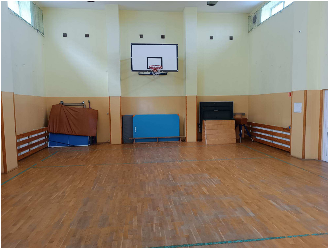
Fot. nr 1 – istniejąca sala gimnastyczna, widoczne zużycie istniejącego parkietu.
