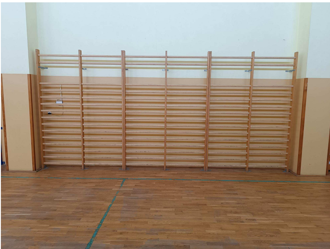
Fot. nr 12 – drabinki gimnastyczne do demontażu, czyszczenia i ponownego zamocowania
