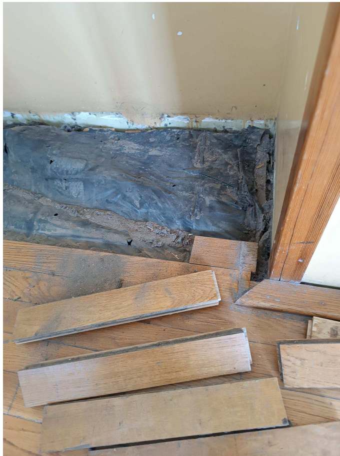
Fot. nr 5 – układ warstw istniejącego parkietu.
