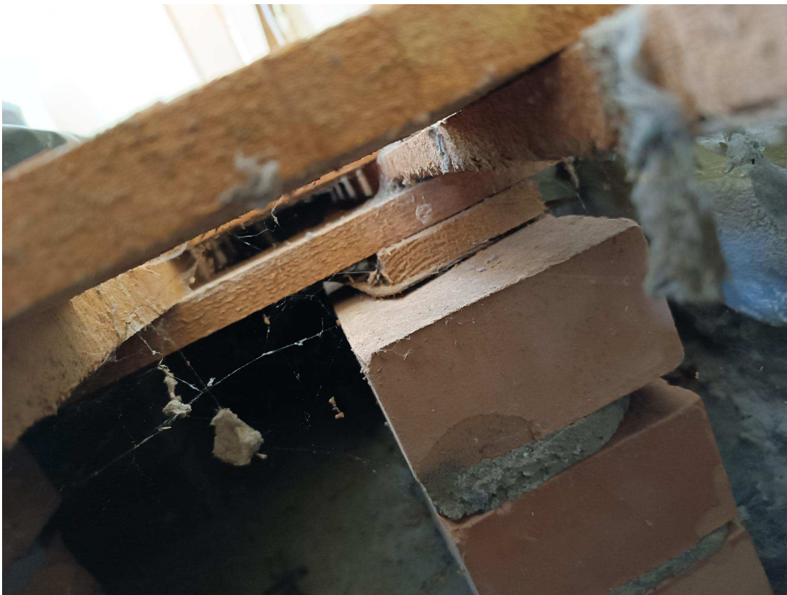
Fot. nr 7 – układ warstw istniejącego parkietu.
