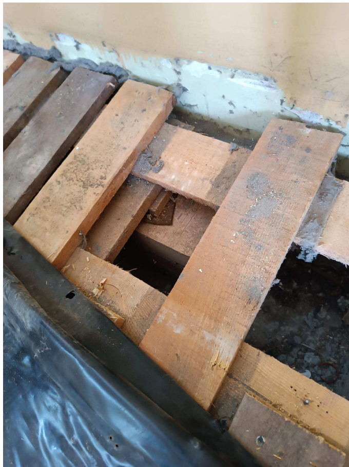
Fot. nr 6 – układ warstw istniejącego parkietu.
